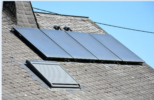
Bei klarem Himmel sorgt die auf dem Hausdach installierte thermische Solaranlage für Wärme und warmes Wasser
