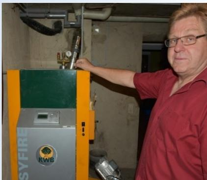
*2013 entschied sich Wolfgang Bartz für eine Pelletheizung (10-30 kW) in Kombination mit einem 1.000-Liter-Pufferspeicher mit Trinkwassermodule sowie zehn Quadratmeter Solarkollektoren auf dem Dach*
