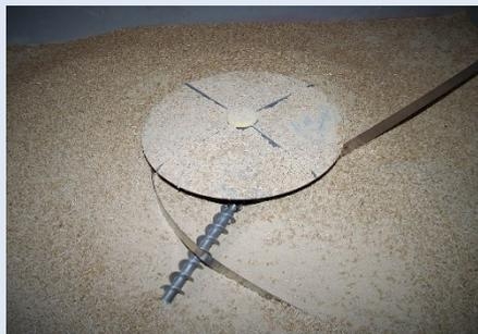
Das Rührwerk im selbstgebauten Pelletlager schafft die bestmögliche Ausnutzung des Lagerraumvolumens, erfordert keinen Schrägboden und eignet sich ideal für quadratische bis rechteckige Lagerräume zuverlässig zur Heizung befördert, möglich. Aus Platzmangel wurde der Pufferspeicher in einem angrenzenden Kellerraum installiert. Aber dies war Dank der geteilten Bauweise der Anlage kein Problem. Der Einbau des gesamten Heizsystems erfolgte 2013 innerhalb von wenigen Tagen.
